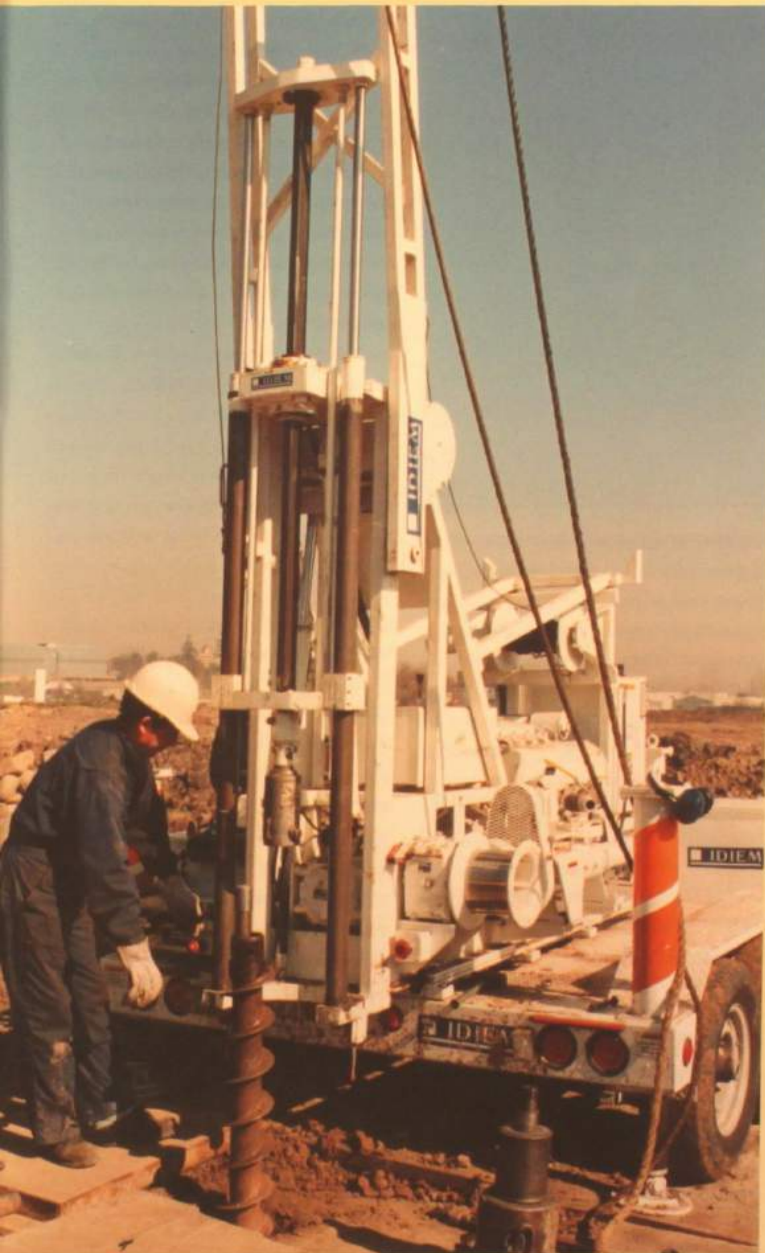
▲ Equipo de Sondaje para realizar Geotécnica en profundidad.
