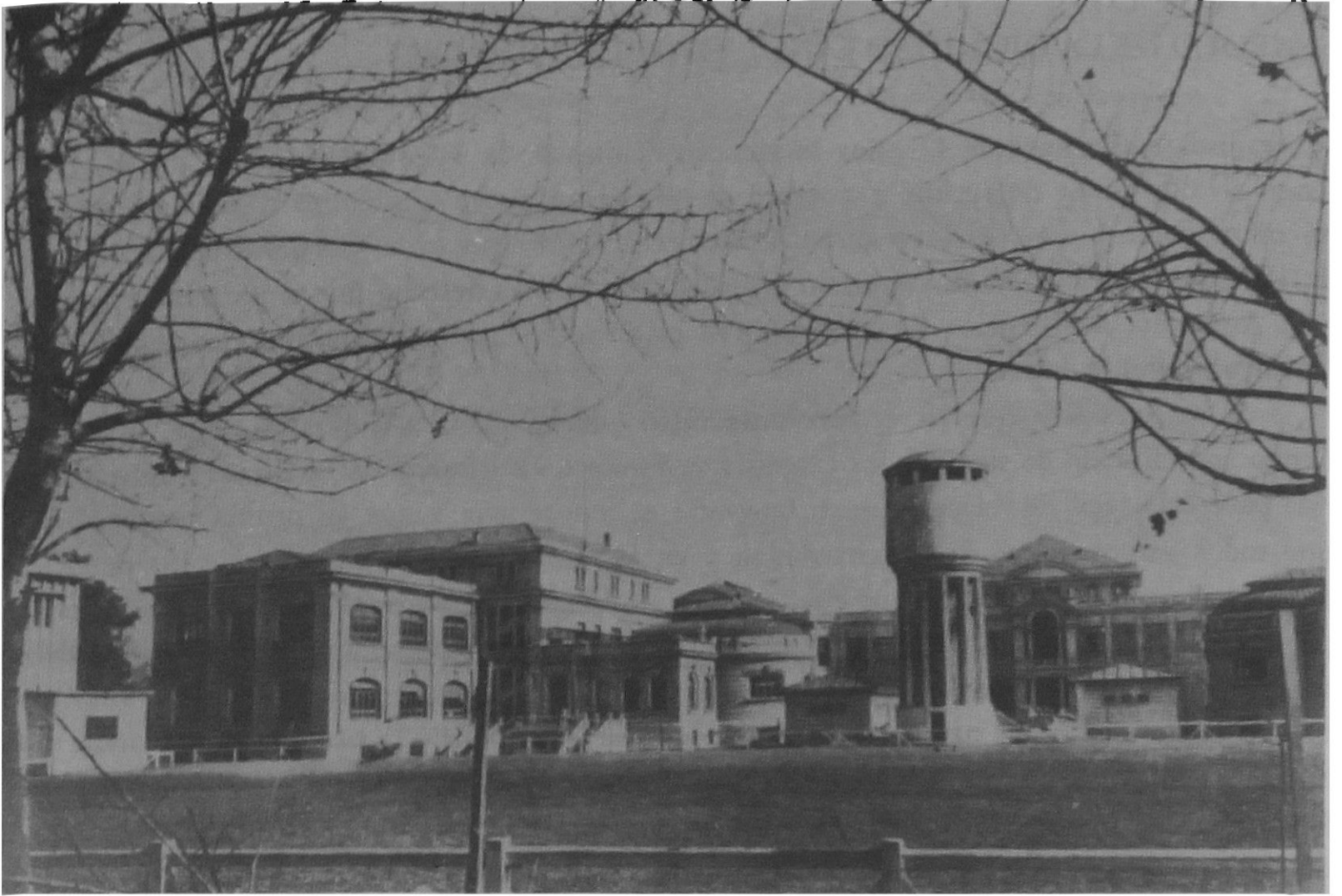
Vista general de la Escuela de Ingeniería de la época
