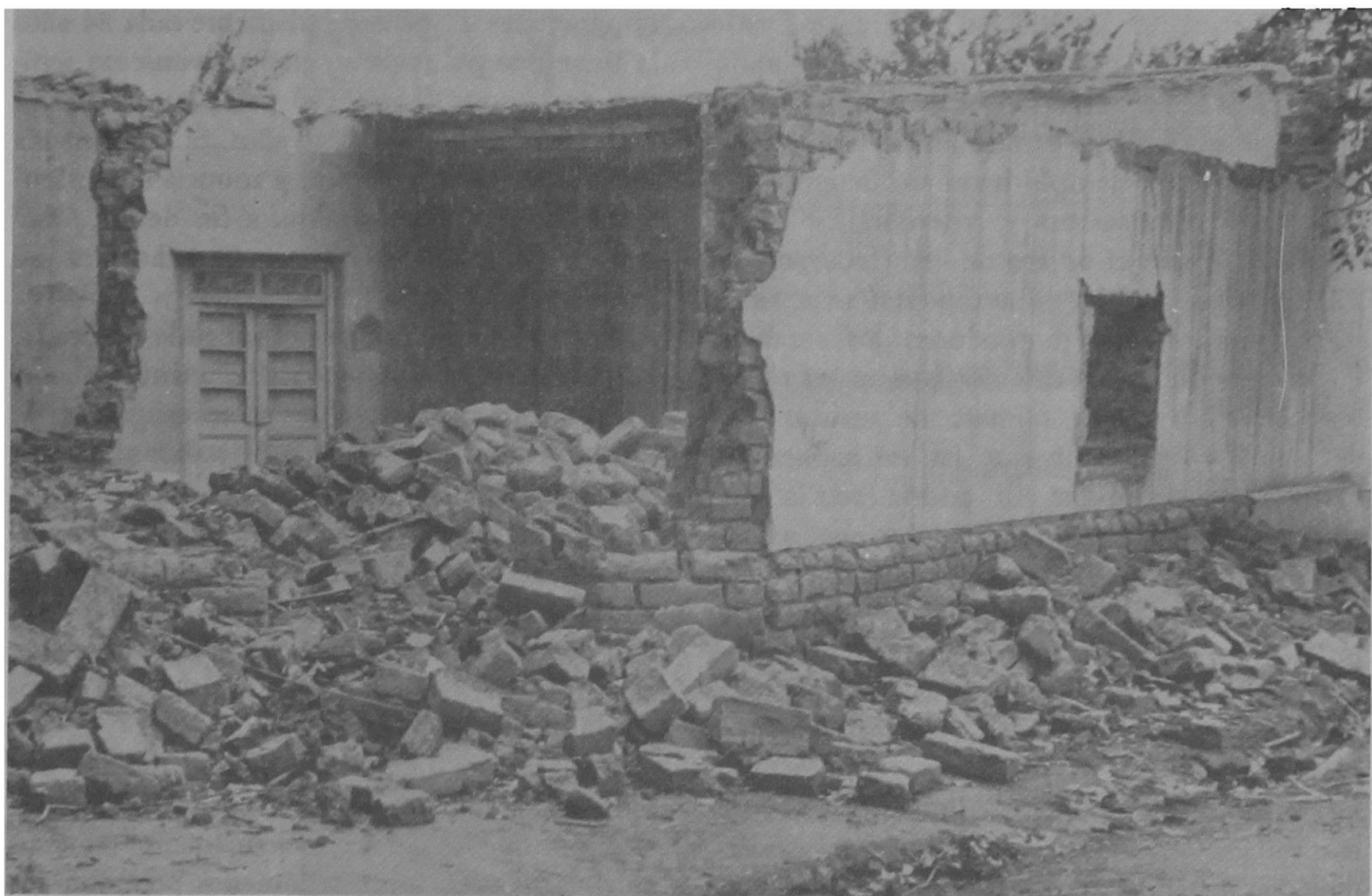
Inmueble destruido por el sismo ocurrido en el Sur en el año 1961.
