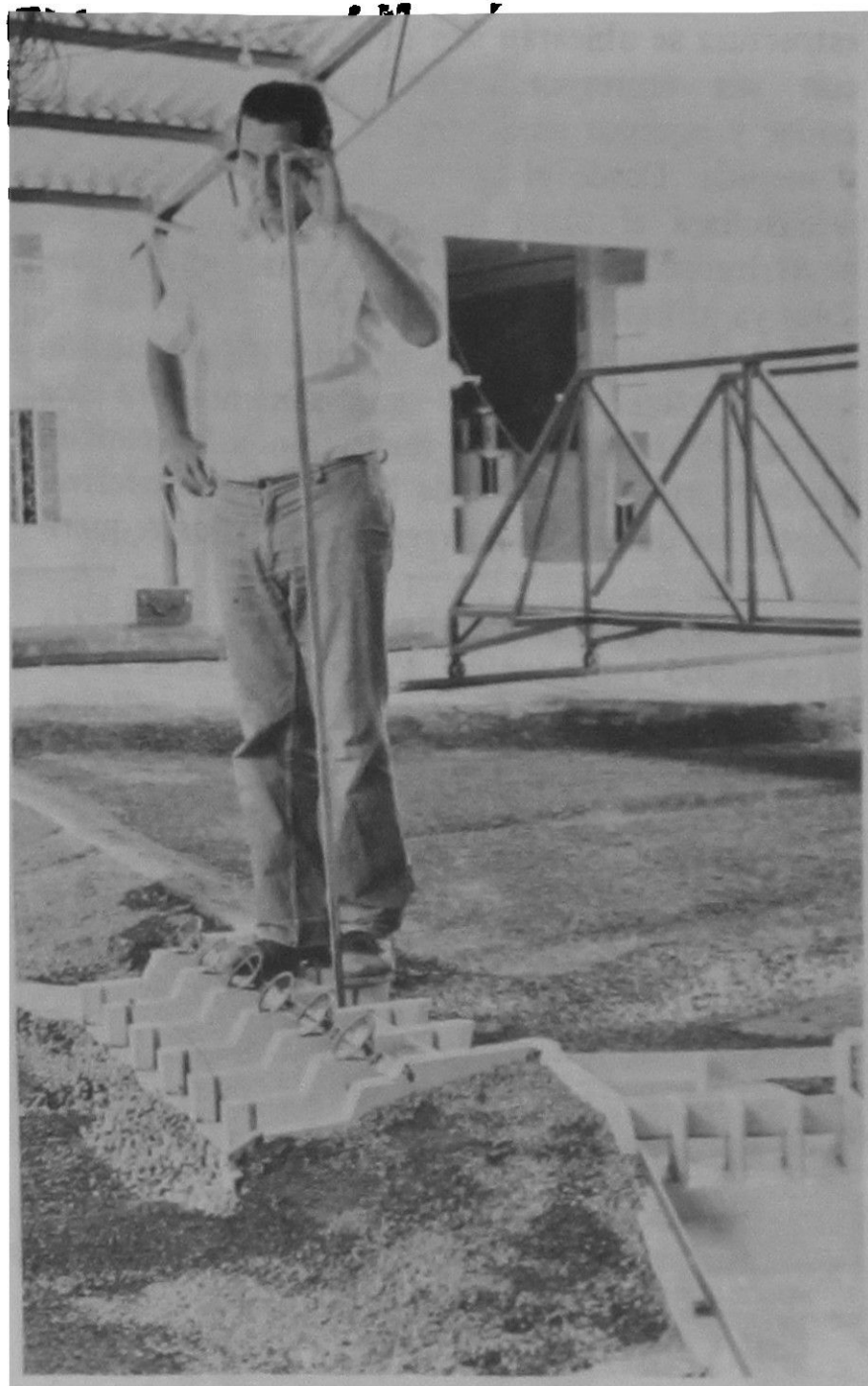
Mediciones de cota de la obras. Barrera Móvil.
