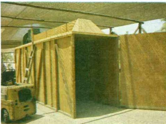
Figura 3. Cámara proyectada y construida de acuerdo a las exigencias y normas de seguridad para realizar un adecuado proceso de gasificación con Anhídrido Sulfuroso.
