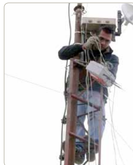
Hollman Enciso de Bogotá-Mesh instalando nodo en la población "La Victoria", Santiago de Chile.
