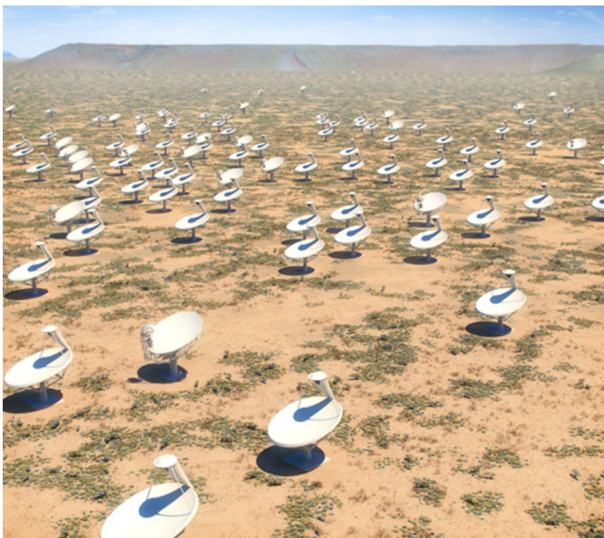
IMAGEN 3. IMAGEN GENERADA POR COMPUTADOR DEL SKA. EL SKA ABARCARÁ UN DIÁMETRO DE APROXIMADAMENTE 3.000 KM Y PRODUCIRÁ APROXIMADAMENTE 100 GB POR SEGUNDO A PARTIR DEL AÑO 2030. FUENTE: WWW.SKATELESCOPE.ORG.
