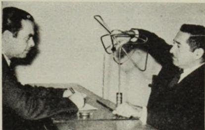
Prueba del tremómetro, para medir movimientos finos de la mano y estabilidad interdigital
