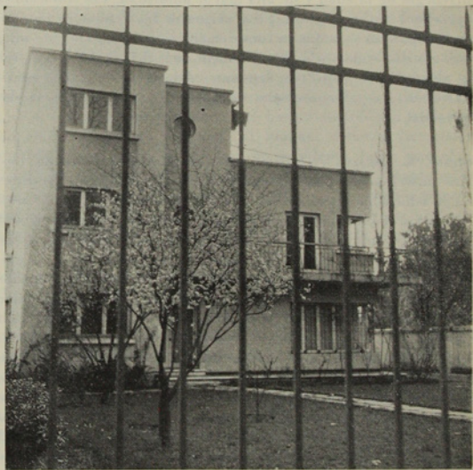
Aspecto del edificio que ocupa el Instituto en Macul (propiedad universitaria)
