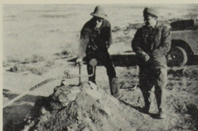
Control de la presión del vapor endógeno, 22 de julio 1960
