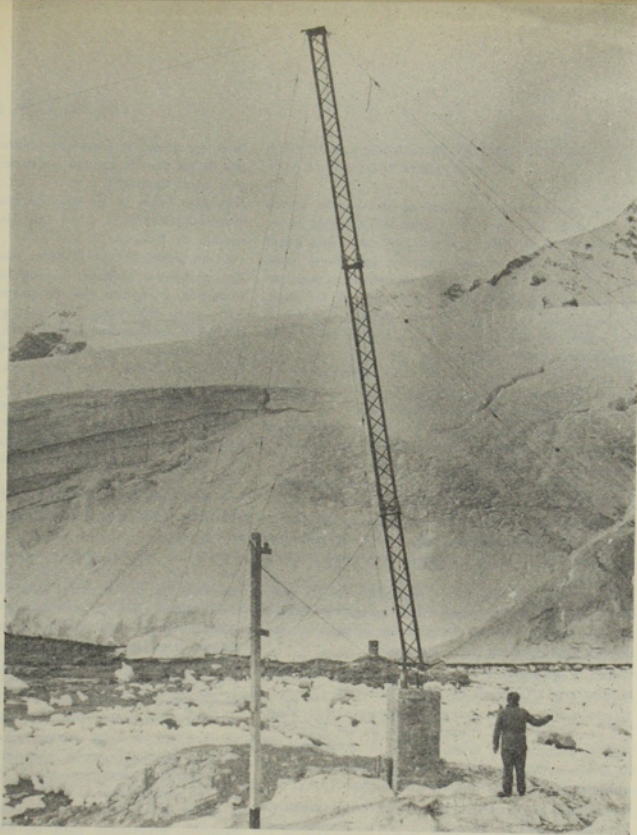
Operando el cambio de posición de una antena en la Base "Presidente González Videla"
