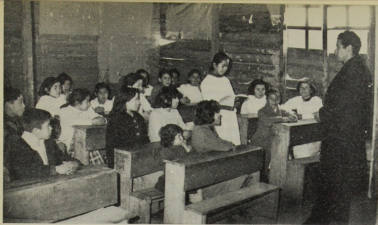
Sala de clases en escuela de la población Lo Valledor, una barraca llena de parches y vidrios rotos
