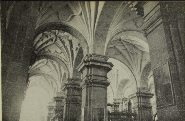
Fig. 9 Cuzco, interior de la catedral: cúpulas de crucerías con nervios estructurales arandelados y nervaduras ornamentales (foto del autor)
