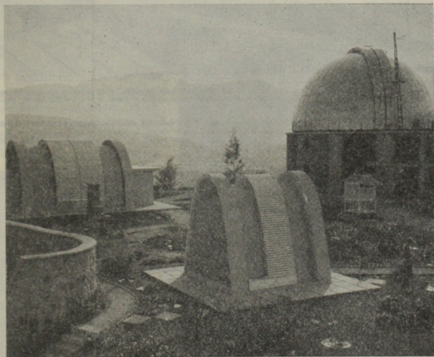
En primer plano la cúpula del círculo meridiano recto , y del instrumento de pasaje . Luego la instalación del control para los relojes de cuarzo, y al fondo la cúpula del Gran Ecuatorial
