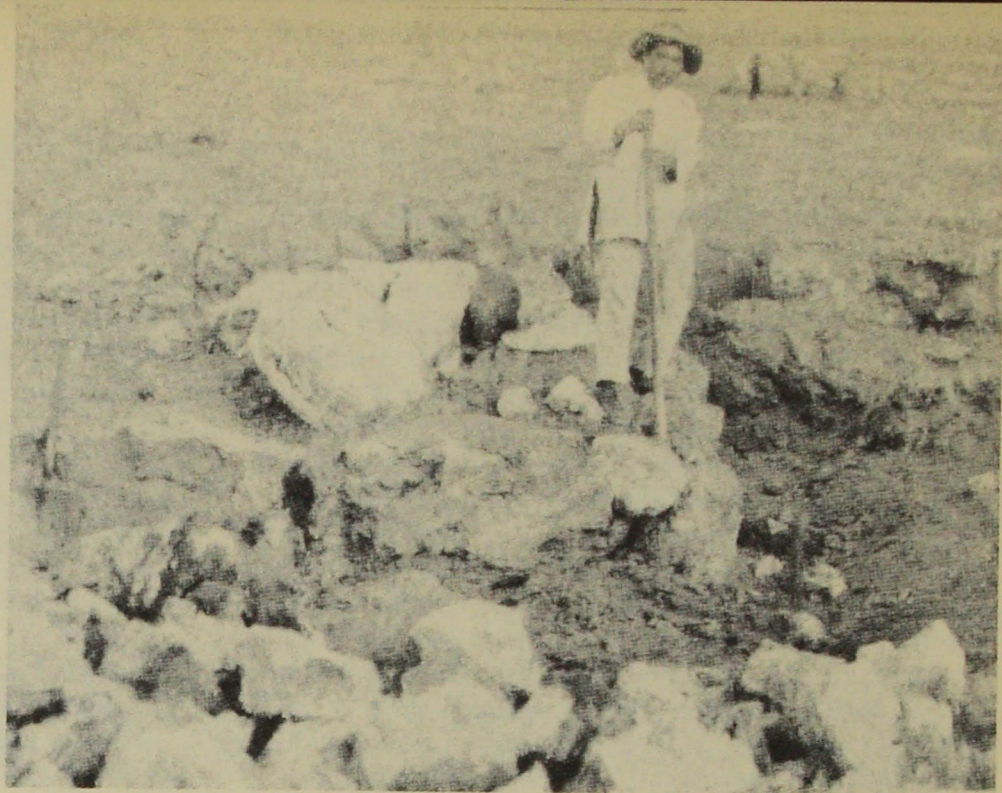
Preparando un barreno para reconocer el espesor y la ley del "caliche" o mineral de nitrato (foto 1912)
