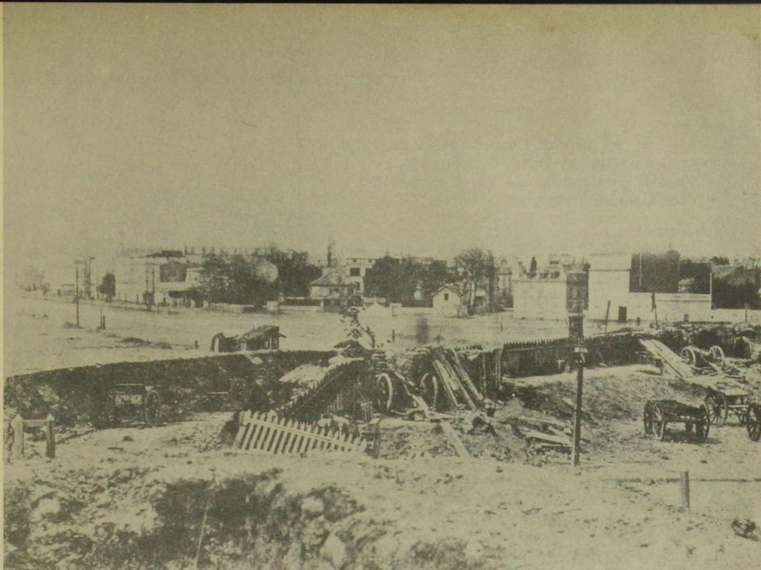
La puerta Maillot y la Avenida Neuilly ( fotografía )
