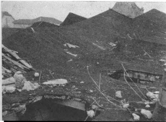
LOSA DE TECHUMBRE DE HORMIGÓN ARMADO DE LA FCA. WEISS DE VALDIVIA. (Ver pág. 29).
