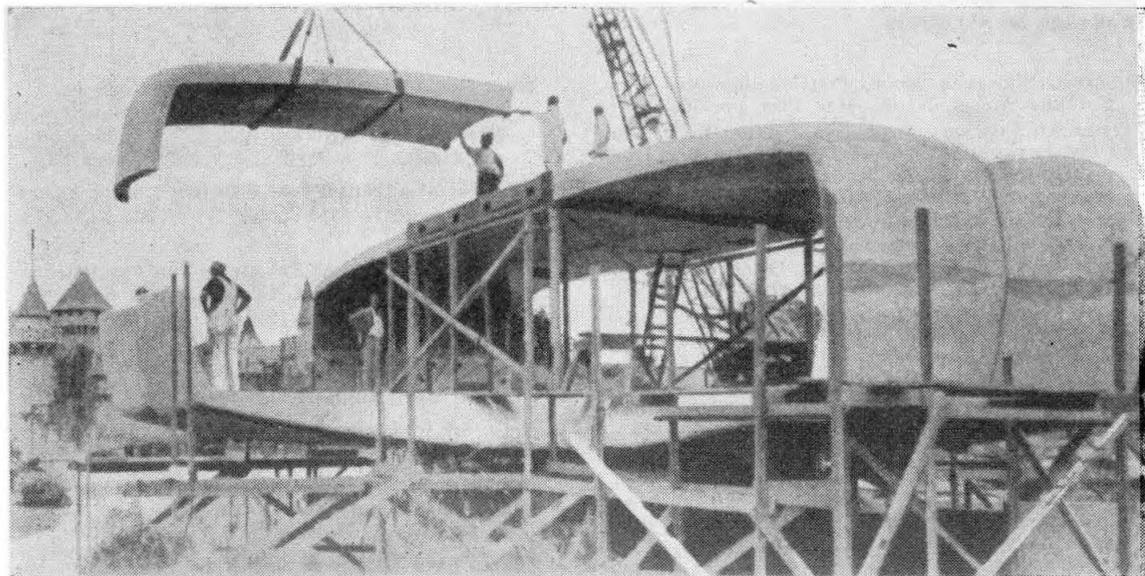
Casa Experimental de la Monsanto Chemical Corp. Los elementos prefabricados fueron integrados mediante adhesivos estructurales sintéticos
