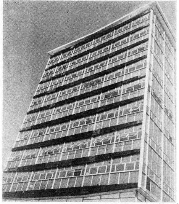
Ahora bien, la cara interna de un muro cortina es a menudo permeable al vapor; se corre el riesgo de que la humedad proveniente del interior de la habitación penetre en el panel y se condense si la temperatura de un punto cualquiera del muro correspondiera a la del punto de rocío.
