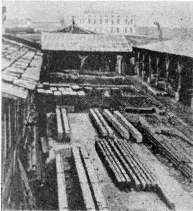
**Primer empleo de jácenas prefabricadas de cemento armado (1892).**
