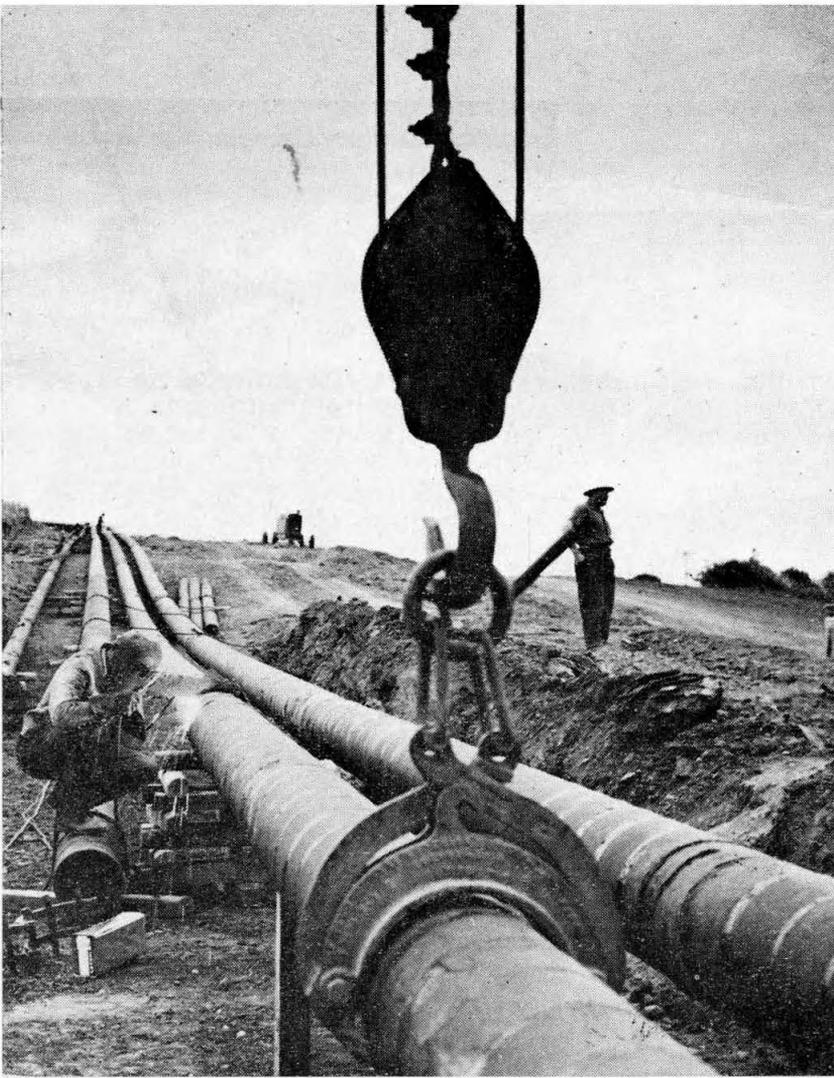
Faena de construcción del Oleoducto de Concón a Maipú. Se utilizaron 116 Km. de cañería de 10 $\frac{3}{4}$ " fabricada por Compañía de Acero del Pacífico S. A.
