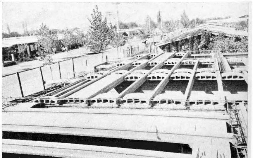
Vista general de la ejecución de la placa Inapreco. Colocadas ya las viguetas pretensadas de 17 cms. de alto, se ha iniciado la ubicación de las bovedillas huecas de mortero de cemento.
