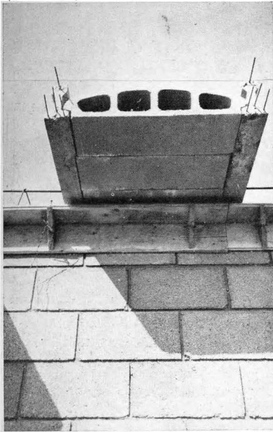
Con el mismo sistema de viguetas pretensadas y bovedillas se resuelven los aleros. Un moldaje recibirá relleno de hormigón que dará la terminación vertical al alero.
