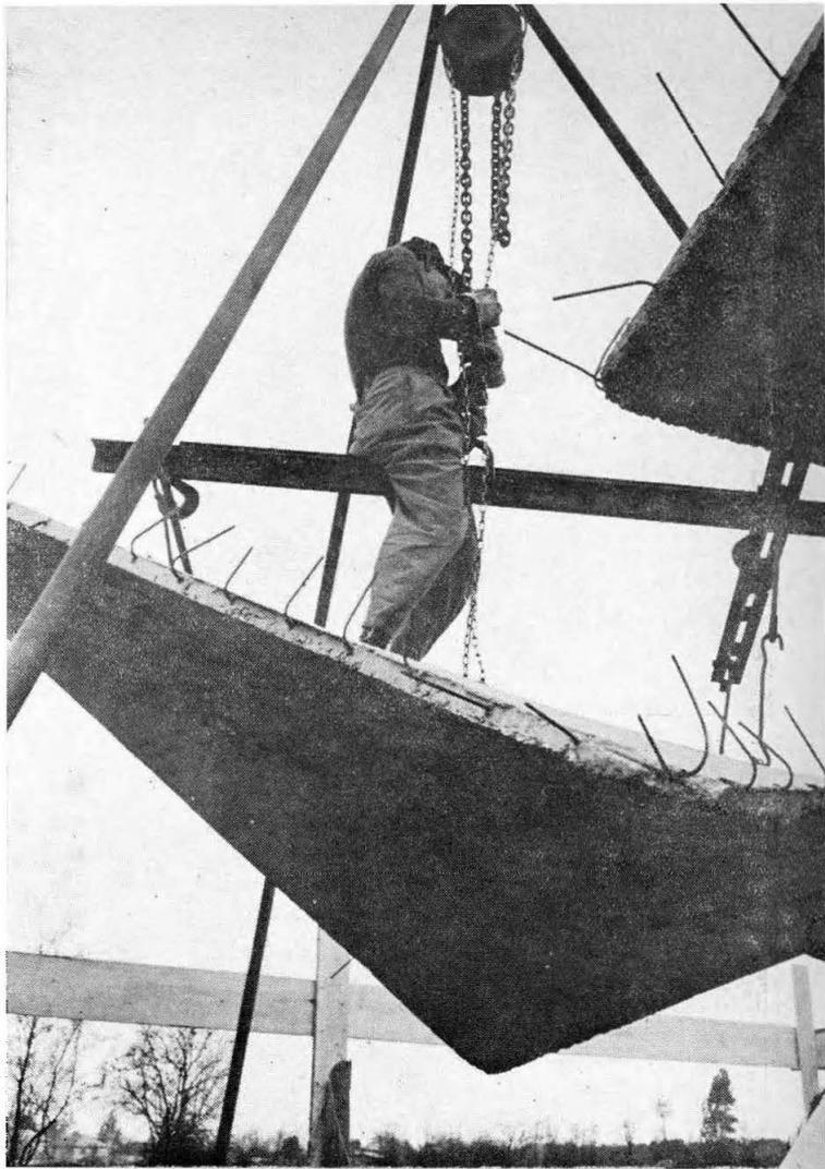
Como es sabido, los paraboloides hiperbólicos generan superficies regladas lo que simplifica en gran medida los moldajes y facilita la prefabricación de elementos que posteriormente pueden acoplarse para constituir estructuras.
