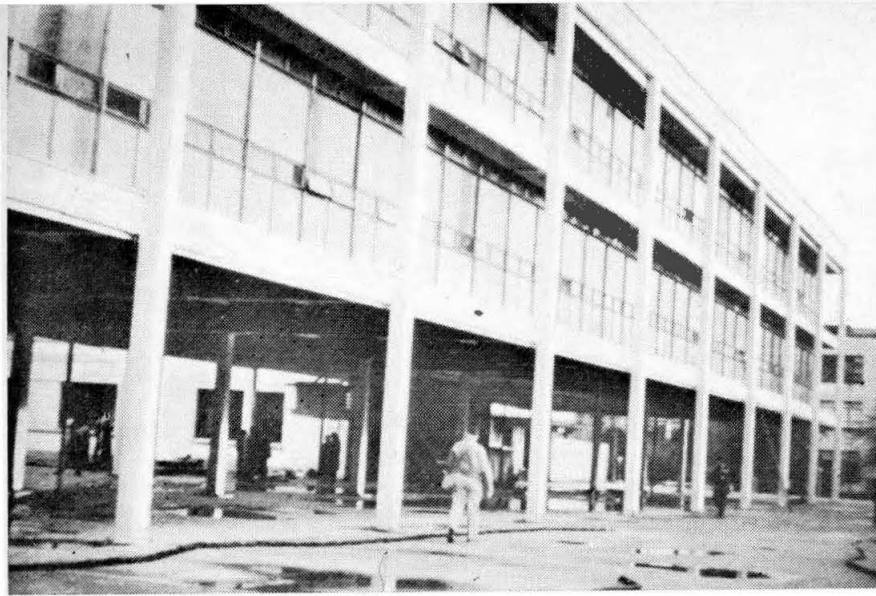
Vista general del edificio con estructura de acero de la Universidad de Concepción. Foto de K. V. Steinbrugge.
