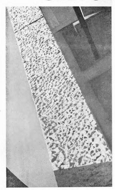
Detalle del cabezal de un muro tratado con RUGASOL. Profundidad de la exposición 5 a 7 mm.
