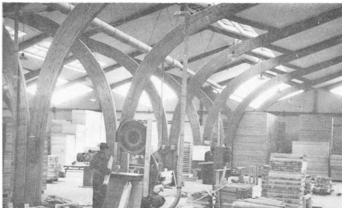
A.—Vista de la planta industrial. Se destacan los arcos laminados de madera.
