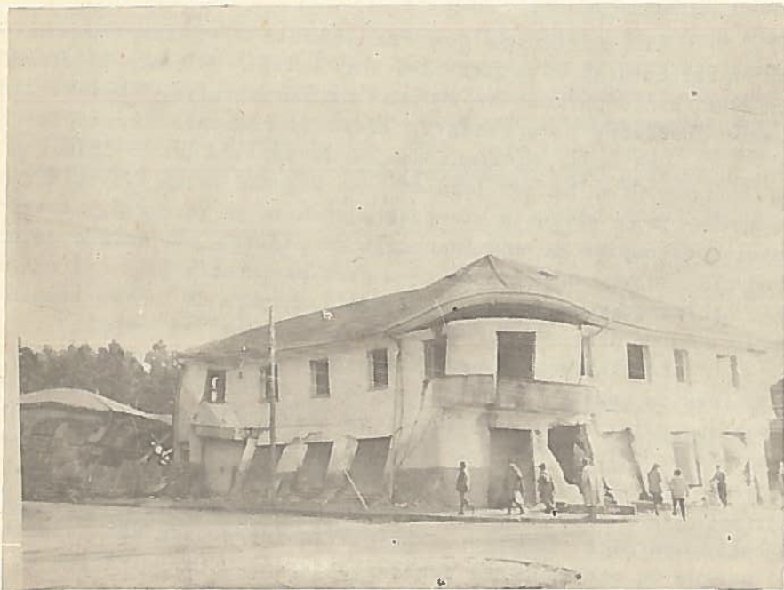
Foto 11. Derrumbe de casas de fabricación ligera, "reforzadas" en concreto, Valdivia
