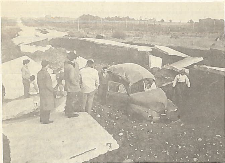
Foto 3. Un auto pequeño aprisionado en una grieta, en el relleno de la ruta entre Puerto Varas y Puerto Montt. El camino era de pastelones
