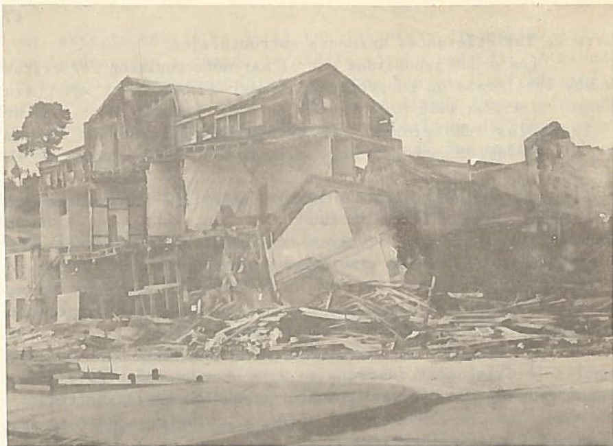
Foto 12 Derrumbe de una casa de construcción heterogénea, Puerto Montt.
