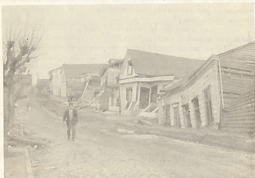
Foto 2. Calle en Valdivia, mostrando efectos de poca coherencia del suelo
