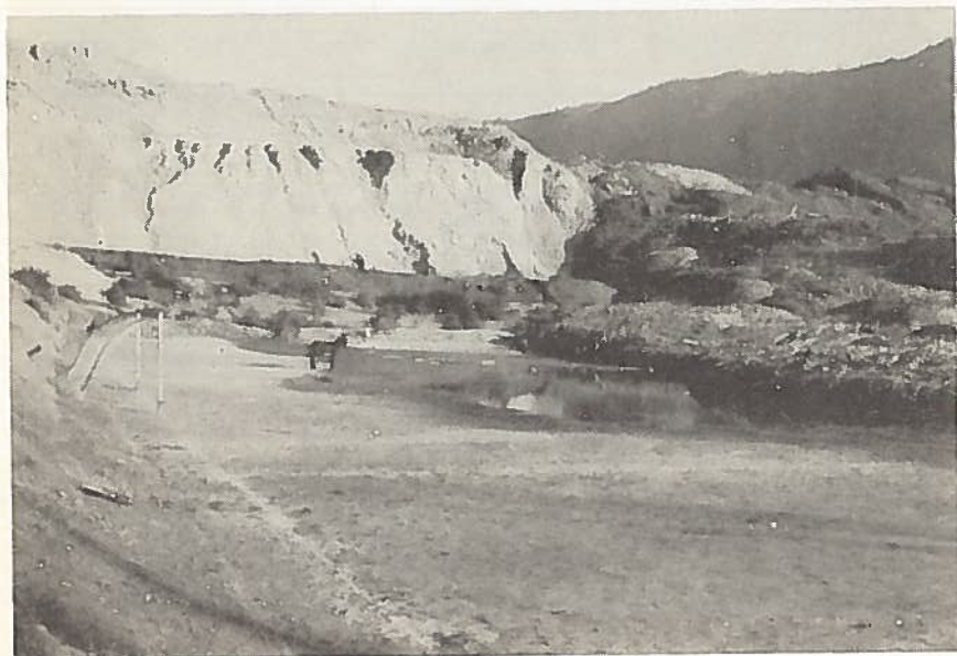
Foto 15. Frente del trenque El Cobre, mostrando un flujo lateral de relave que inundó una cancha de fútbol. Vista mirando hacia el ESE. 30 de Marzo de 1965.
