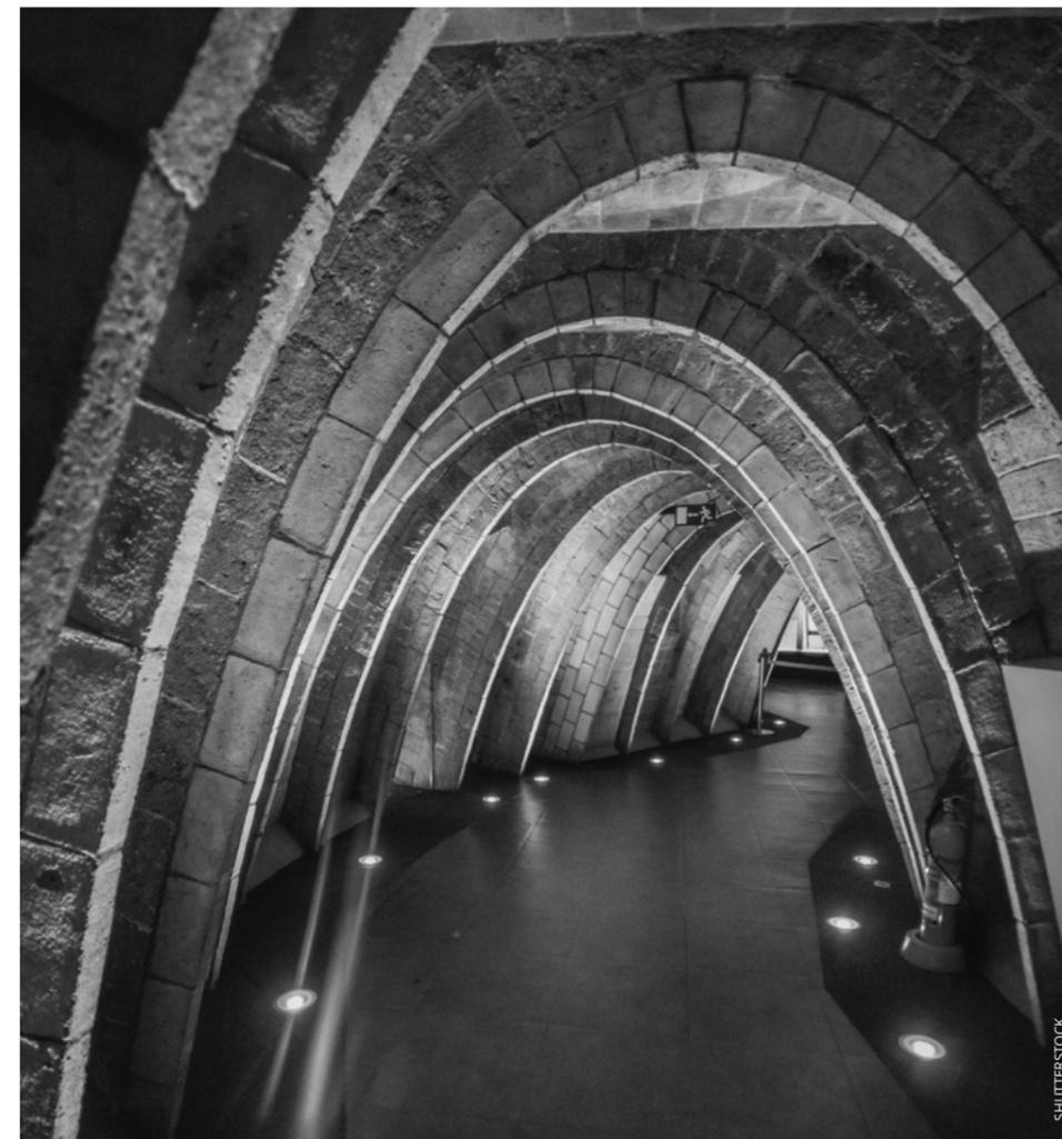
propósitos arquitectónicos, la forma invertida es la que se denomina antifunicular. Además, en arcos catenarios de igual longitud, se verifica que a medida que la altura aumenta, disminuye el empuje horizontal en los puntos de apoyo, lo que posibilita la construcción de estructuras altas con mínima fuerza lateral (Gescovich & Vedoya, 2023).
